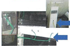
โครงสร้างโลหะ / การต่อสายดินกับเครื่องจักร
